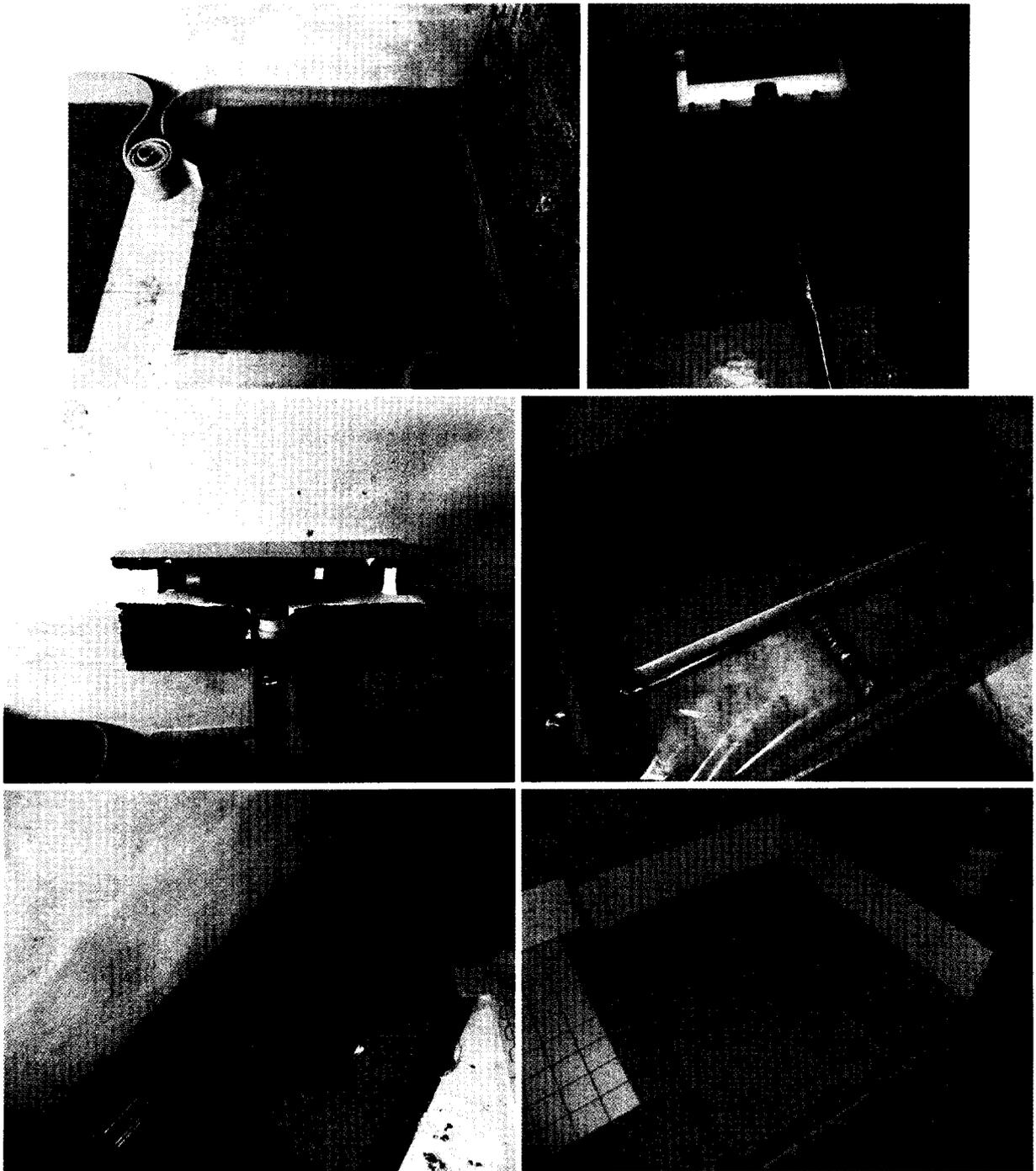
Oben links: Gummigranulatmatte aus "Schallschutzset-Duschelement DallFlex Wall" lose ausgelegt und mit PE-Abdichtungsbahn lose abgedeckt.
